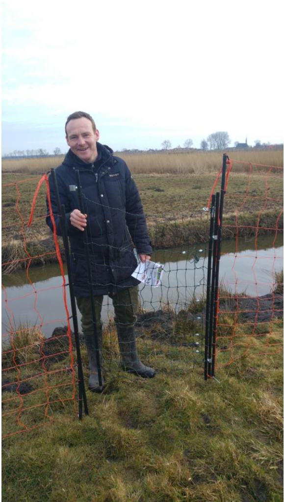
De hekken moeten in elkaar worden gezet, geplaatst en spanningsloos uitproberen.
