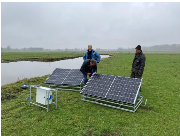
Foto 1. Plaatsing van de pomp met zonnepanelen in februari.
